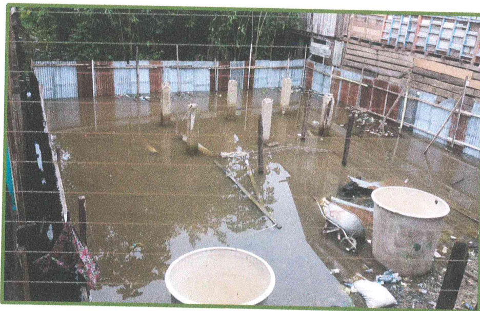
Imagen del 13/01/2020 : El área de terreno destinado a la obra de contingencia se encuentra cubierta de agua en su totalidad, por el progresivo incremento del nivel de creciente del Río.
